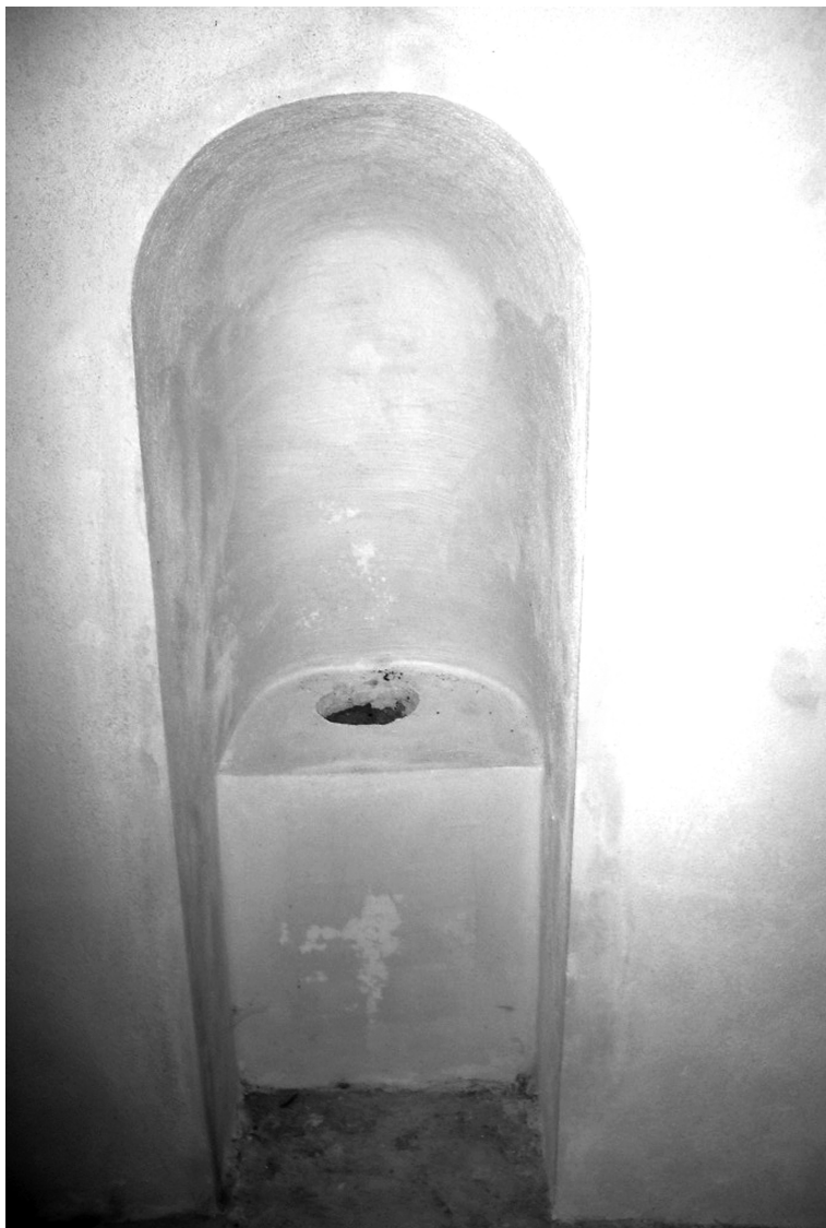
Fig. 1 - Savoca: Chiesa Matrice. Colatoio. È evidente il foro centrale per la raccolta dei liquami cadaverici.
