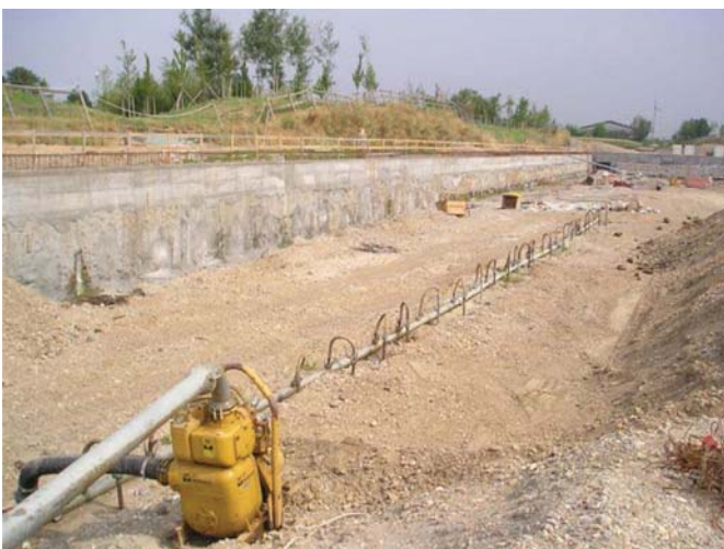
Fig. 5 - Esempio di installazione di una serie di well point; sullo sfondo sono visibile le paratie in calcestruzzo (Verziano, agosto 2004) - Example of a series of wellpoints installed; in the background, concrete bulkheads are located (Verziano, August 2004)
