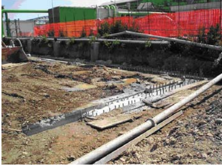
Fig. 4 - Dettaglio di alcune sezioni durante la costruzione delle paratie laterali (Verziano, giugno 2004) - Details of some sections during the construction of bulkheads (Verziano, June 2004)
