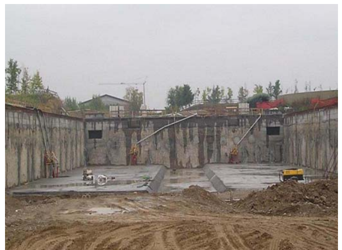
Fig. 6 - Costruzione del pavimento della vasca, dopo l'installazione dei dreni (Verziano, settembre 2004) - Construction of the tank floor after drain installation (Verziano, September, 2004)
