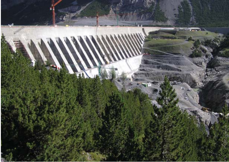
Fig. 4 Paramento di Valle della Diga di San Giacomo - Downstream end by the San Giacomo di Fraele dam
