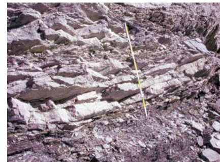
Fig. 6 Ammasso roccioso di tipo B a componente calcarea marnosa, con orizzonti di marne laminare e sottili interstrati di argilliti fissili - The type B formation is composed of marly limestone with layers of laminated marl and fissile shale
