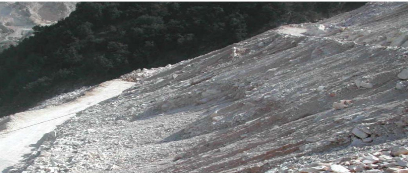
Fig. 11 - Ravaneto di Fosso Borrone-Monte Bettogli: zone di dissesto in prossimità della strada di arroccamento della cava - Fosso Borrone-Monte Bettogli quarry dump: instability areas close to the quarry roads
