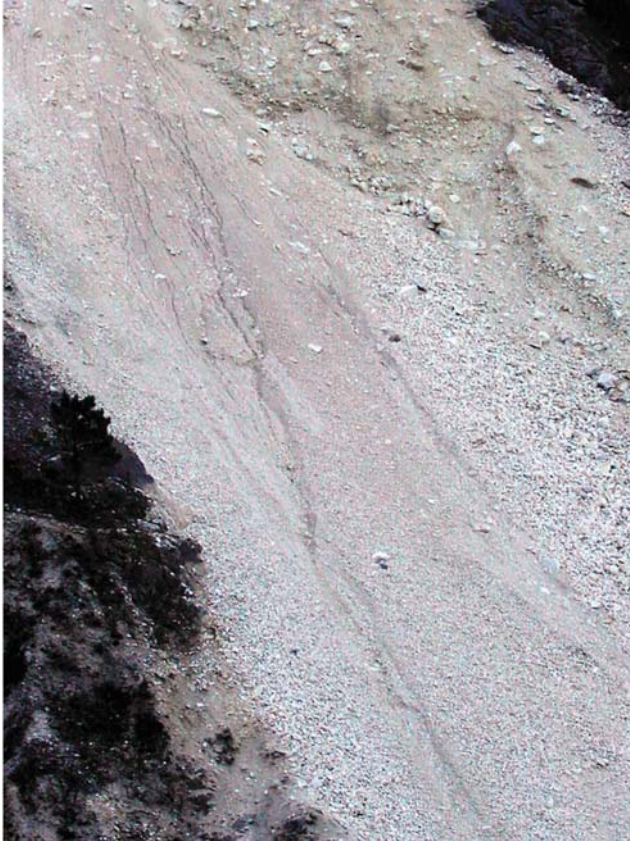
Fig. 10 - Ravaneto di Fosso Borrone-Monte Bettogli. a: erosione per ruscellamento diffuso. b: canale inciso da un debris flow - Fosso Borrone-Monte Bettogli quarry dump. a: sheet erosion; b: track of a debris flow
