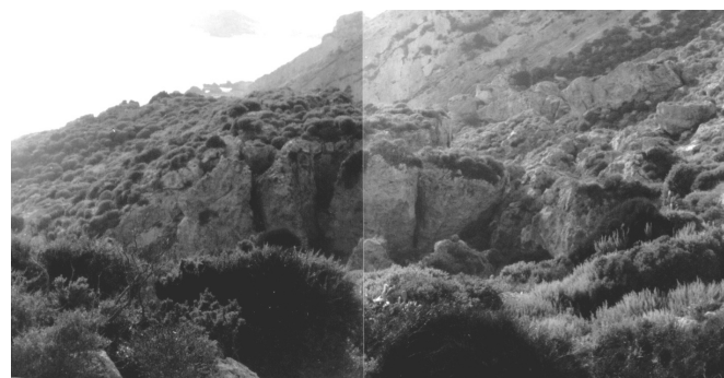
Fig. 12 - Particolare del rigonfiamento al piede del lateral spread di località Cadula - Bulging of Calcare di Base at the foot of the lateral spread at Cadula
