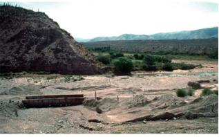
Fig. 28 - Un ponte sul Ferrocarril "G.ral Belgrano", completamente sepolto dalle colate detritiche ed oggi assolutamente inutilizzato
