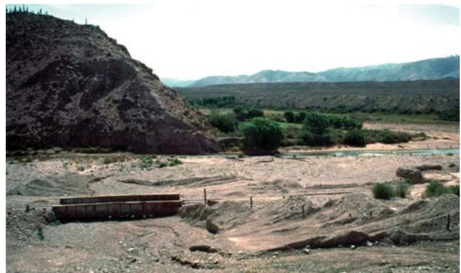
Fig. 28 - Un ponte sul Ferrocarril "Gral Belgrano", completamente sepolto dalle colate detritiche ed oggi assolutamente inutilizzato
