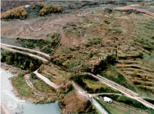
Fig. 3 - Il tratto d'alveo interessato dal movimento franoso de "Le Mottacce", ripreso immediatamente dopo l'evento (foto: Walter Dragoni) - The reach of river bed affected by "Le Mottacce" landslide, taken immediately after the occurring of the event (photo by Walter Dragoni)
