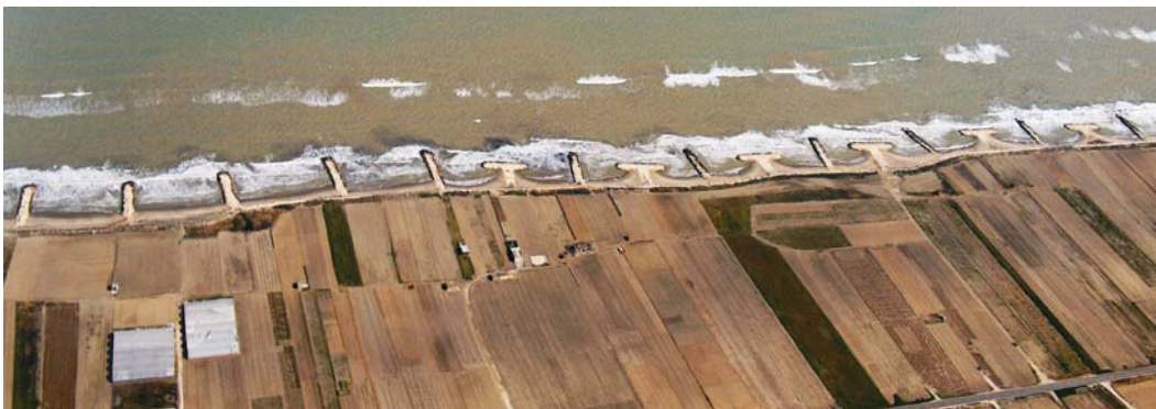
Fig. 8 - Pennelli a T realizzati per correggere l'eccessiva distanza tra i pennelli preesistenti - T-shaped groynes built to rectify the excessive spacing between some existing groynes
