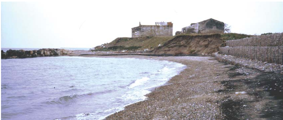
Fig. 13 - Esempio di gradino di erosione della spiaggia sottocorrente rispetto all'opera di difesa - Example of a step of the shoreline downdrift of defense structure
