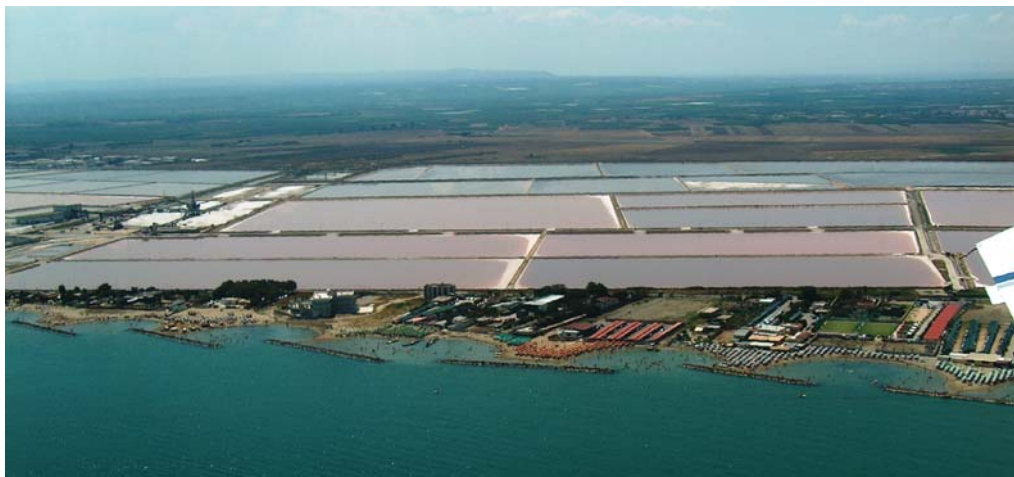
Fig. 4 - Frangiflutti in prossimità del porto di Margherita - Breakwaters near the Margherita harbour
