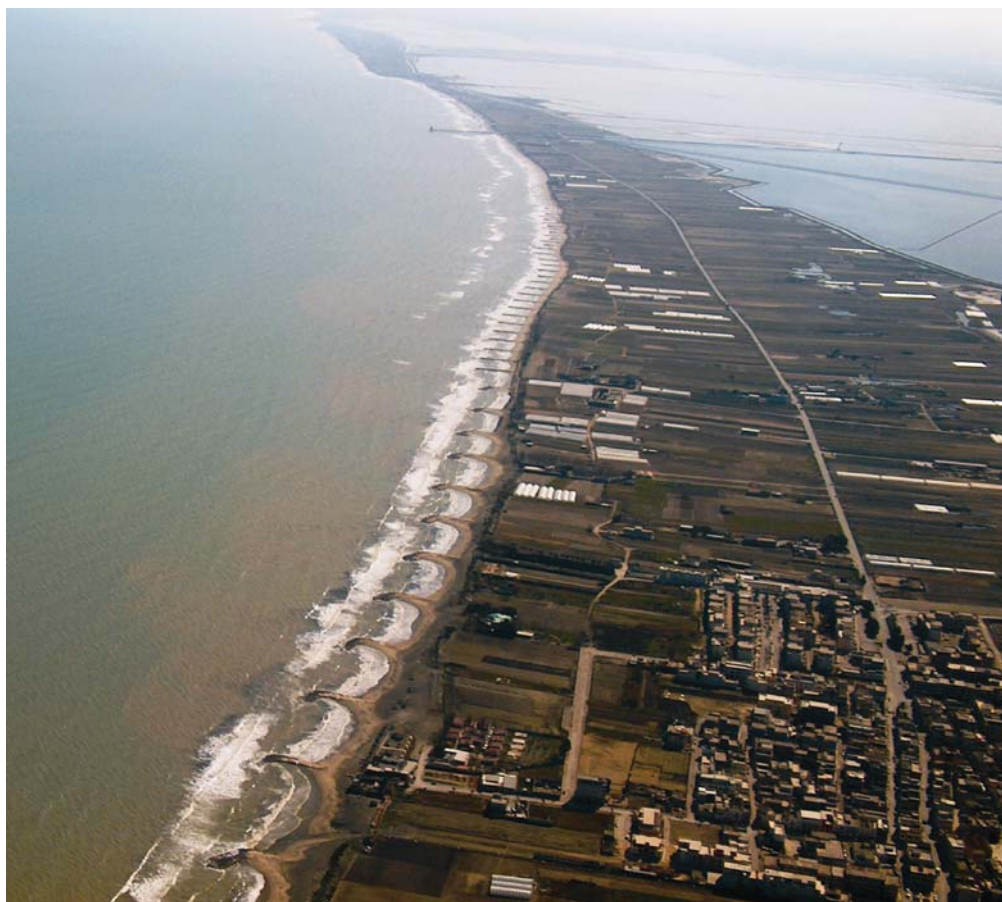
Fig. 6 - Campi di pennelli nei dintorni di Zapponeta - Groyne fields near Zapponeta
