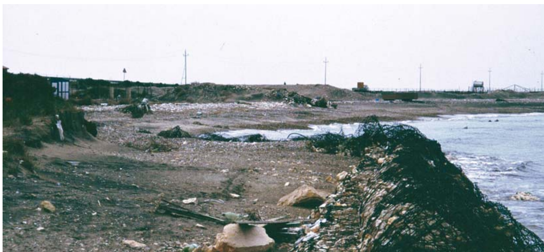
Fig. 5 - Gabbionate sottoposte all'azione delle onde - Gabions under wave action
