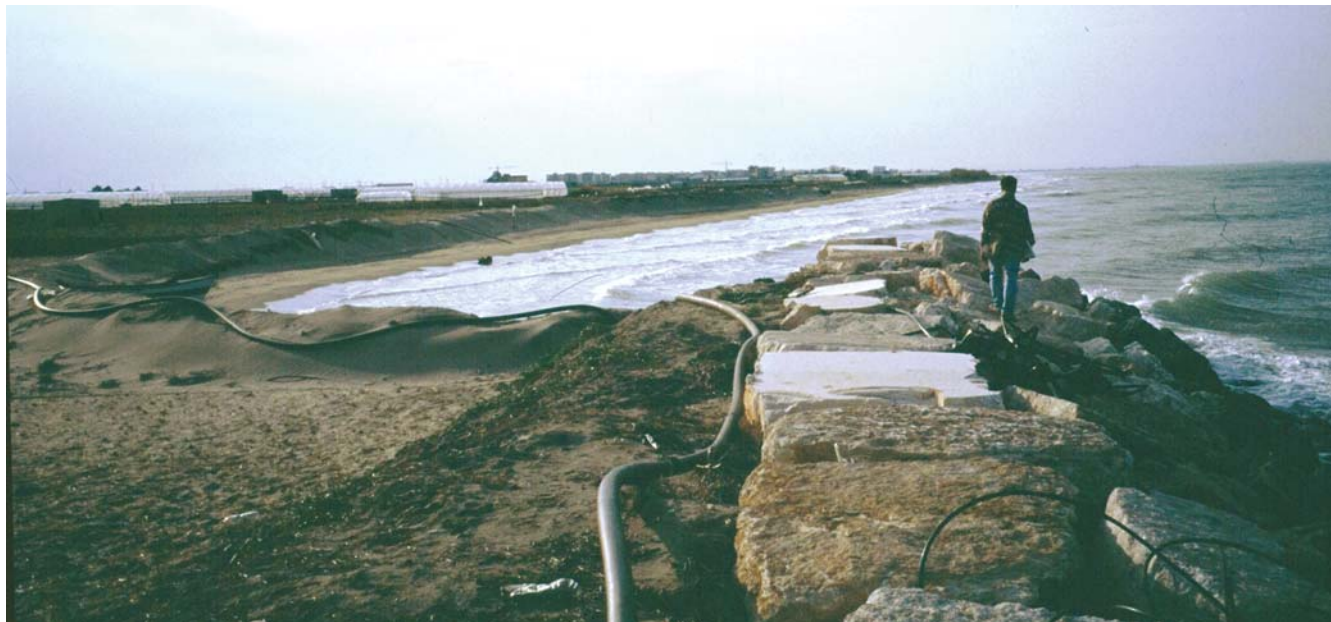
Fig. 14 - Intervento diretto di un proprietario e conseguente erosione sottocorrente - Direct landowner intervention and resulting downdrift erosion
