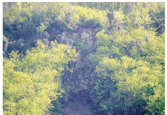
Fig. 4 - Veduta della zona di coronamento della frana n. 3 e della sottostante cornice di lava frantumata - View of the crown zone of landslide no. 3 and of the fractured lava cliff below it
