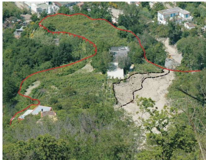
Fig. 17 - La frana 4 sul terrazzo del glacis (la linea rossa ne segue l'orlo esterno); la linea tratteggiata nera rimarca i limiti del deposito rilasciato dalla colata lungo il fianco esterno della curva, costituito in larga parte da tronchi (foto di S. Perriello Zampelli) - Effects produced by landslide 4 on the terraced glacis (the red line marks the terrace rim); the dashed black line marks the border limit of the debris deposit released at the outer bank of the right bend, largely composed of wood (photograph by S. Perriello Zampelli)
