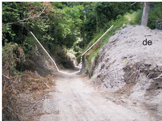
Fig. 14 - Effetti provocati dal passaggio della frana 5 lungo l'incisione che disseca il glacis. La linea gialla segue l'attuale profilo della valle (visto da monte) di uno dei tratti a sezione stretta; il segmento tratteggiato indica il fianco arretrato, per erosione di sponda, a seguito del transito della colata; si noti la forma a V del fondo, denotante l'escavazione operata dalla colata; de: deposito rilasciato su un viottolo che risaliva il fianco della valle - Effects of landslide 5 flow along the incision dissecting the glacis. The yellow line marks the present cross profile of one of the narrower valley sections (view towards downvalley); the dashed segment marks the valley flank retreated due to undermining as a result of the flow motion; note the V-shaped floor testifying scouring in the pre-existing access track; de: debris deposited on an upvalley dipping track cut in the valley flank
