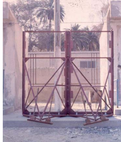
Fig. 10 - Un modulo della parete in fase di assemblaggio sulla spiaggia durante l'esperimento Reggio Calabria 1994 - Experiment RC 1994: the wall in the assembling phase
