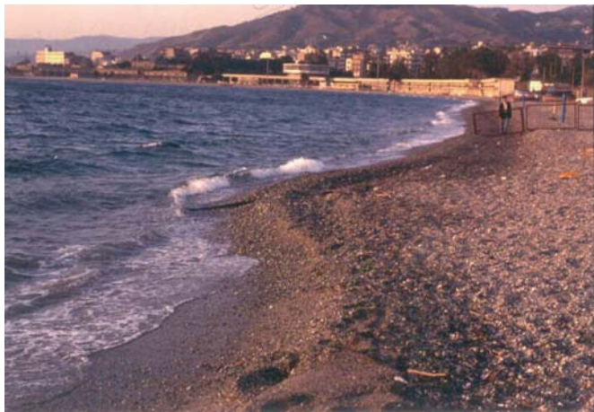
Fig. 11 - Esperimento 1994: accrescimento della spiaggia a tergo della barriera - Experiment RC 1994: beach accretion in the lee side of the barrier
