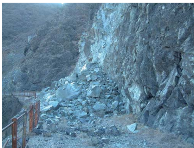
Fig. 14 - Dettaglio della frana di Barberino: crollo in roccia lungo la strada comunale - A detail of the Barberino landslide: the rock fall long the municipal road
