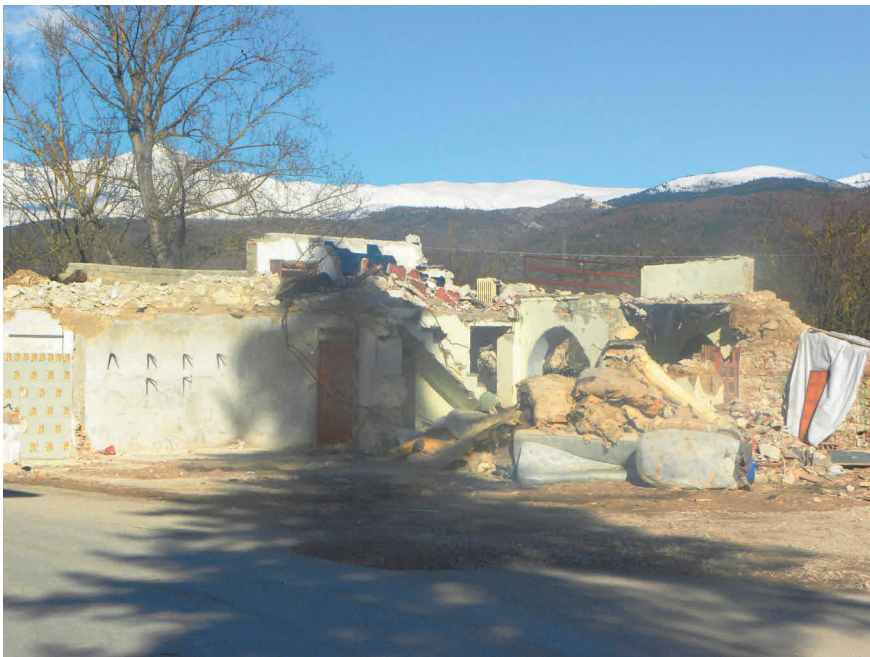
Figure 13 e 14. Ingenti danni e macerie a Onna.
