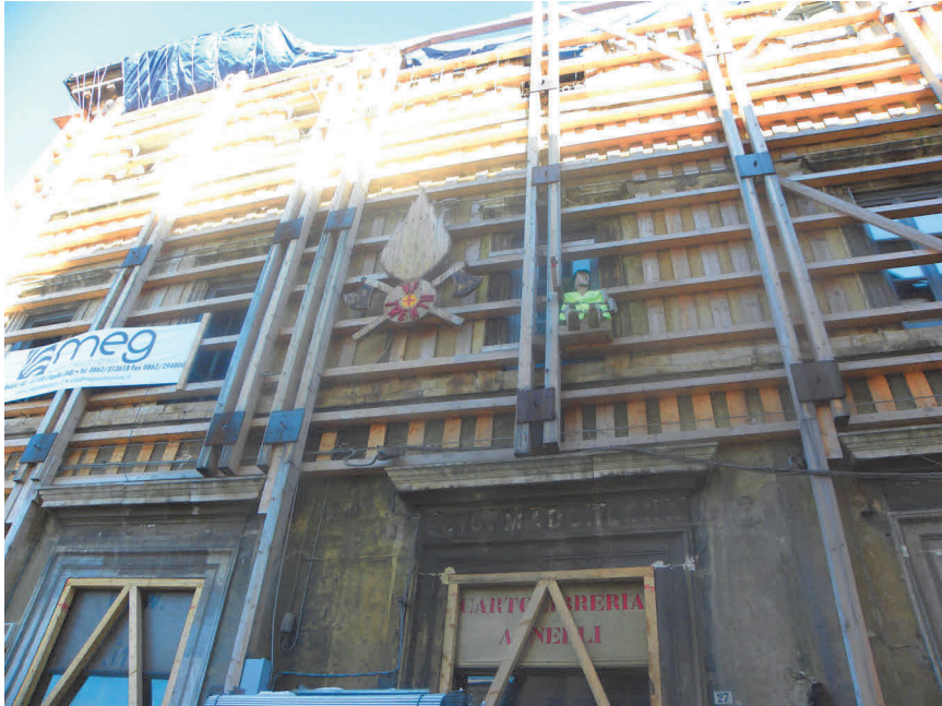
Figura 5. Esempio di opera di puntellamento per la messa in sicurezza di un edificio nella zona di piazza del Palazzo (a L'Aquila).
