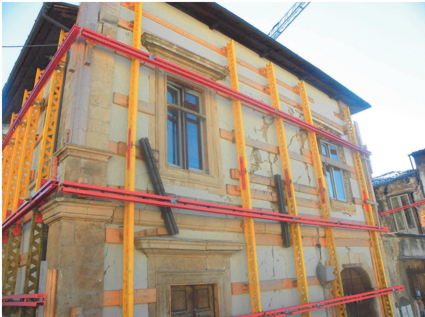
Figura 6. Esempio di opera di puntellamento per la messa in sicurezza di un edificio in prossimità della piazza di San Pietro a Coppito (a L'Aquila).
