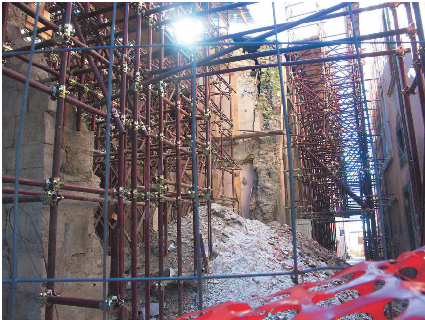
Figura 3. Ponteggi di protezione in una via del centro storico della città di L'Aquila.
