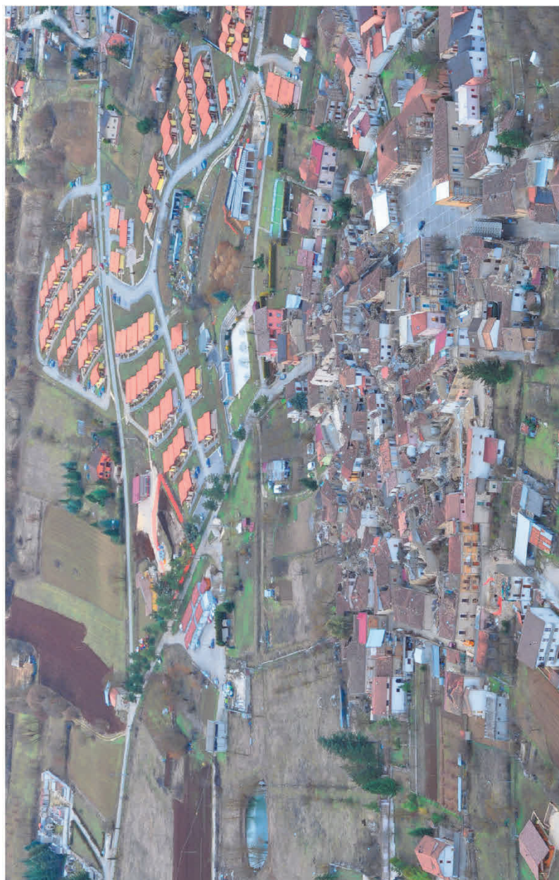
Figura 5. Il comune di Villa Sant'Angelo. In primo piano gli ingenti danni al preesistente tessuto urbano; in secondo piano i moduli abitativi provvisori (M.A.P.).
