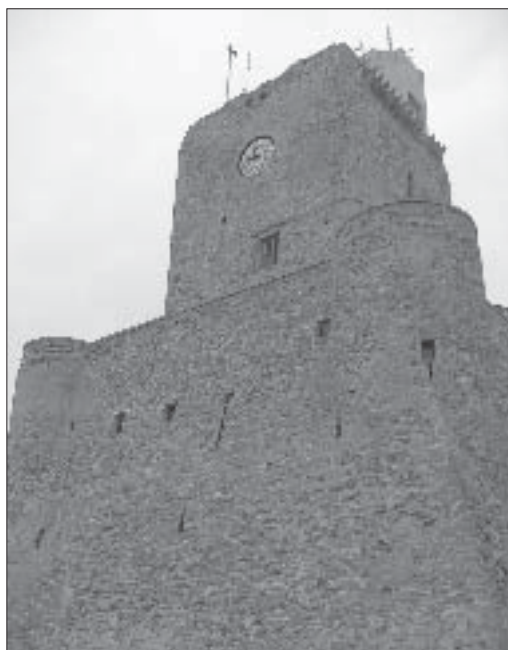
Fig. 14 – Il castello di Termoli (aprile 2007).
