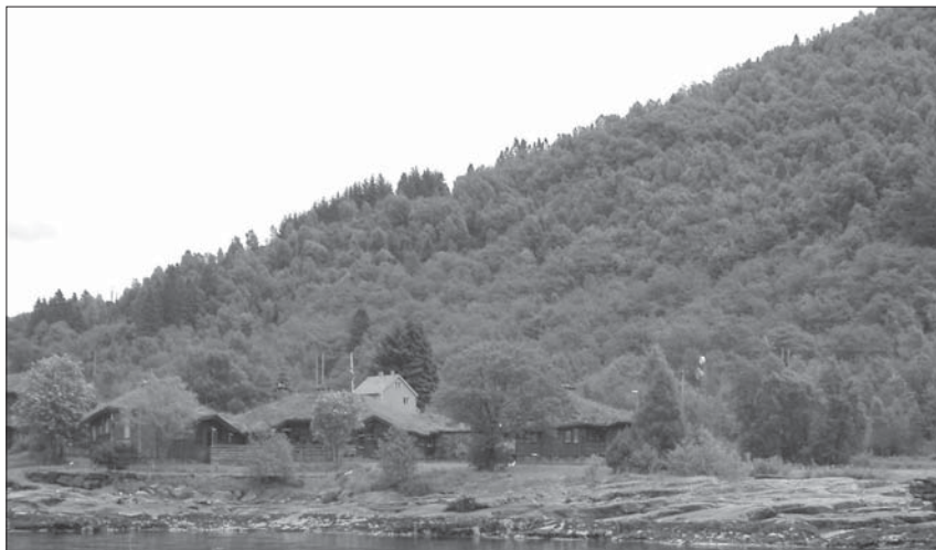
Fig. 26 – Struttura ricettiva di Brekke, «affacciata» sul fiordo e a ridosso di ripidi versanti. La struttura è caratterizzata, oltre che da una posizione isolata e altrettanto amena, dal susseguirsi orizzontale di più location con i tetti coperti di vegetazione. Foto: C. Pesaresi, 2006.
