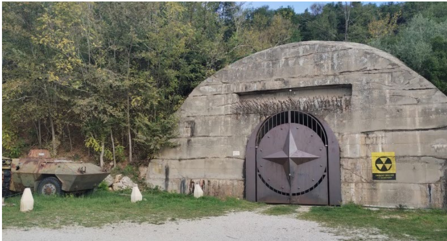
Fig. 5 – L'ingresso del bunker Soratte.
