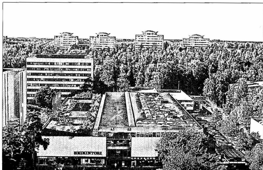
Foto 1 - Il centro commerciale di Tapiola.
